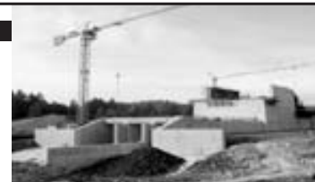
Bild: Auslaufbauwerk Hochwasserrückhaltebecken Wolterdingen
